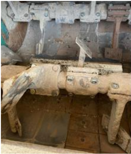
Figura 8a – Limpeza do misturador
