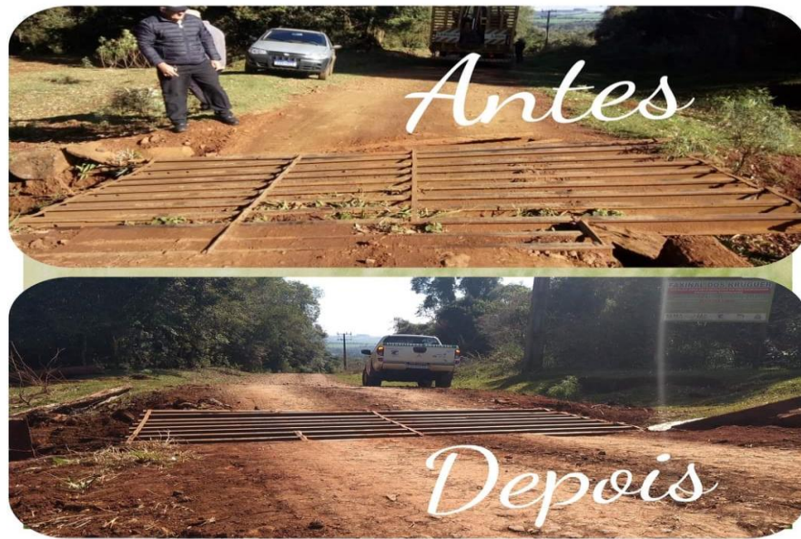
Imagem 09 - Preservação da área de faxinal, com melhorias da infra estrutura, como reformas de cercas, mata burros, etc. Fonte: SEMMA.
