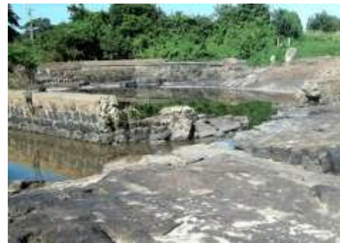
Figura 8 – Dique de contenção Fonte: Autor (2012)
