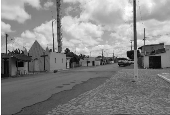
Figura 11 – Estradas ruins que dão acesso ao centro de Parazinho
