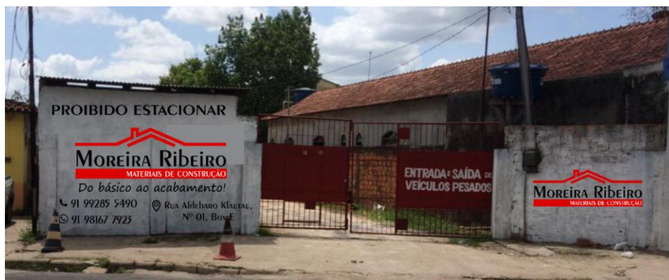
Figure 6 - Fachada do depósito
