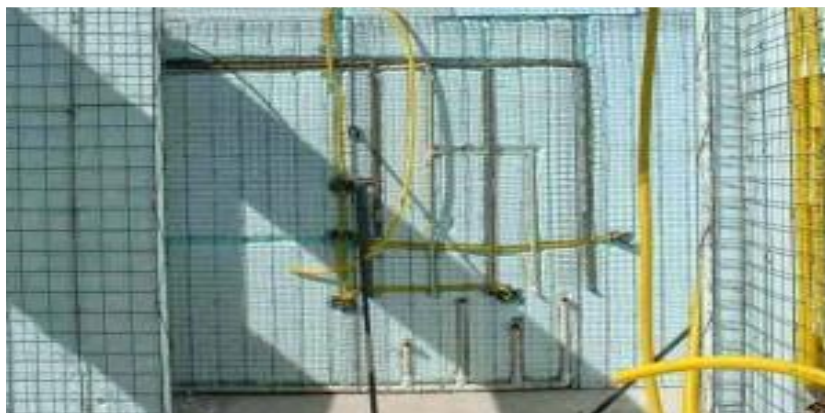
Figura 9 - Traçados feitos para instalação elétrica e hidráulica
