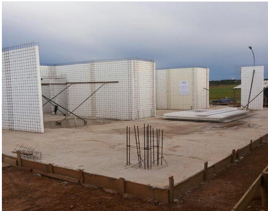
Figura 5 - Fixação dos Painéis
