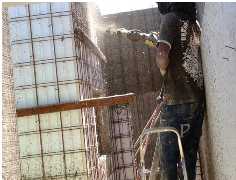
Figura 11 - Revestimento das Paredes
