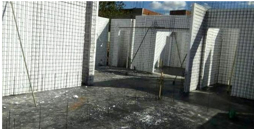
Figura 7 - Paredes Montadas
