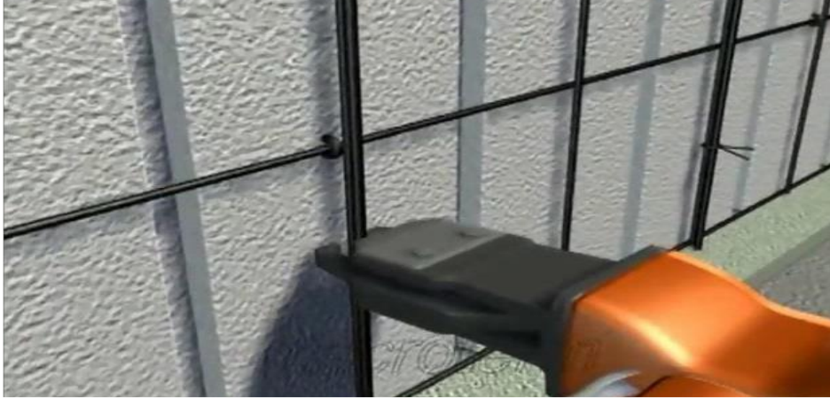
Figura 4 - Grampeador com grampos de aço para amarração dos painéis nos arranques
