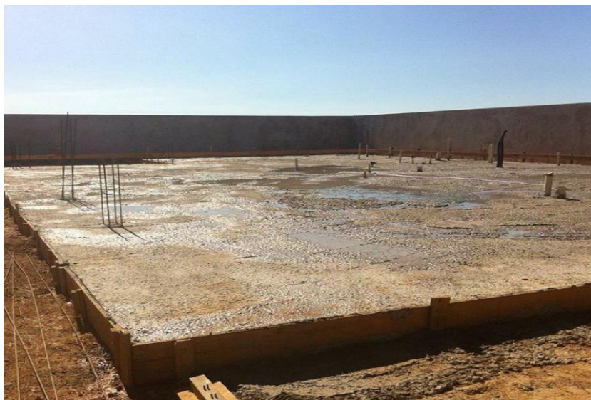
Figura 3 - Radier concretado
