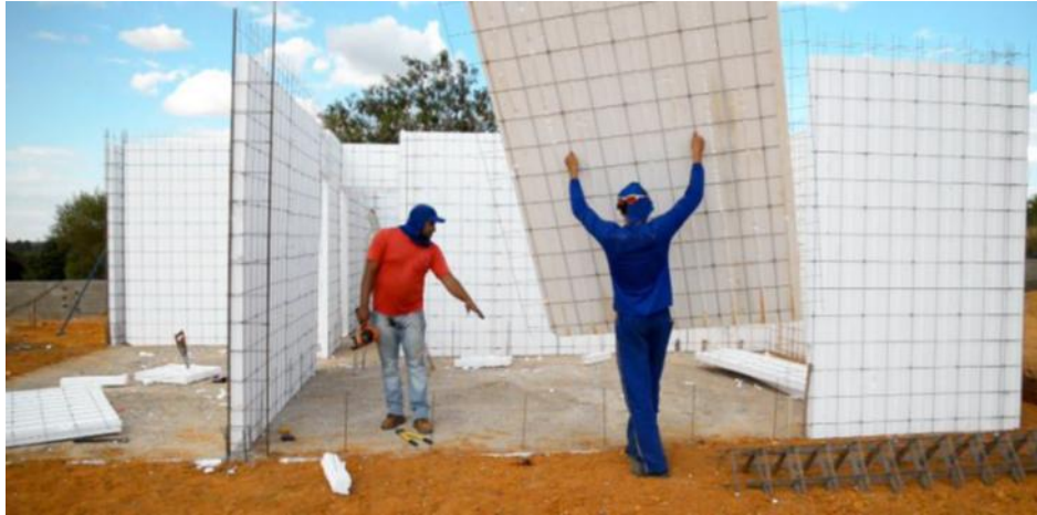
Figura 6 - Facilidade de transporte dos painéis
