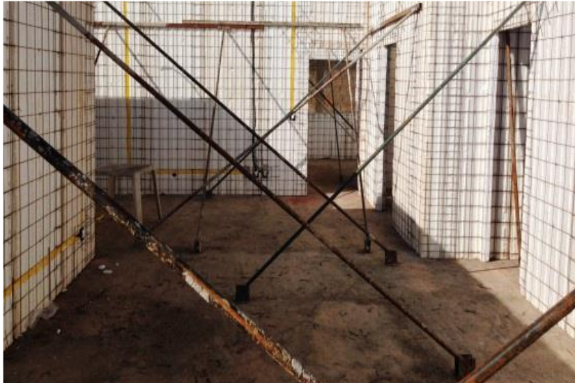
Figura 8 - Detalhe das réguas e escoras
