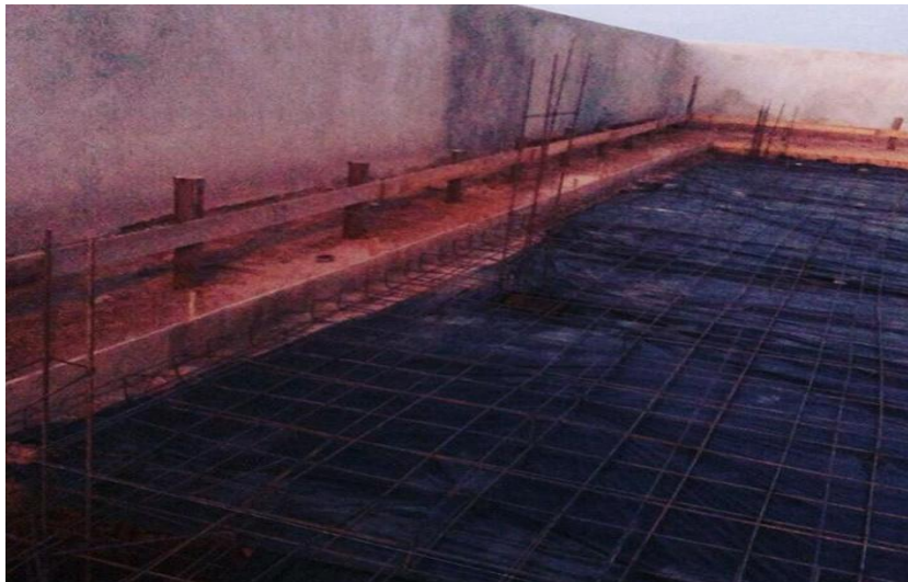
Figura 2 - Radier pronto para concretar
