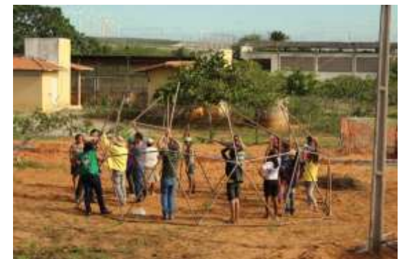
Figura 14 - Ação conjunta para a construção da estufa geodésica na comunidade de Brinco de Ouro. Foto: SEBRAE RN.
